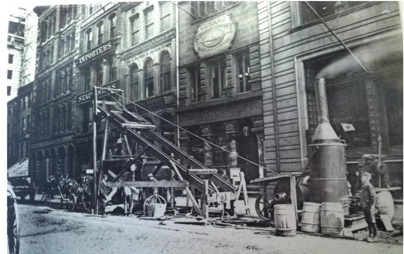
Dampfbetriebene Lochmaschine zur Lokalisierung und Freilegung von Infrastrukturobjekten
